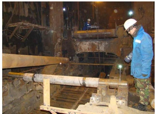
Рис. 4. Измерение стоек установки рам МНЛЗ
