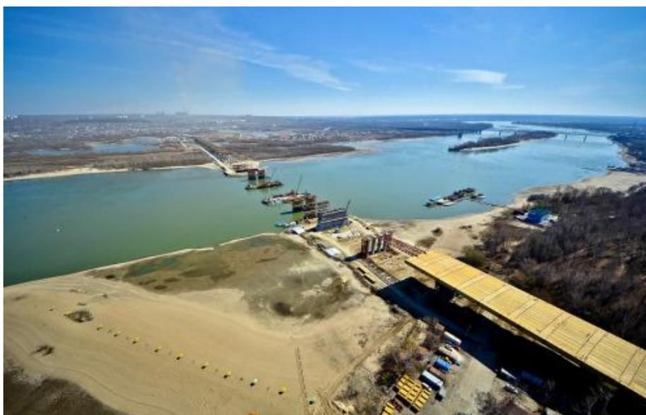
Рис. 2. Начальная стадия надвигки затяжки арочного пролетного строения
