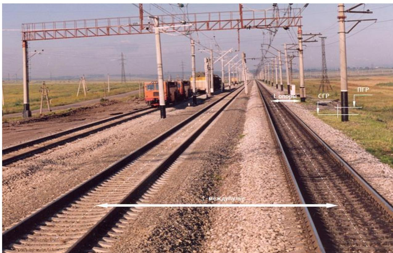
Рис. 1. Привязка при ремонтах пути относительными методами
