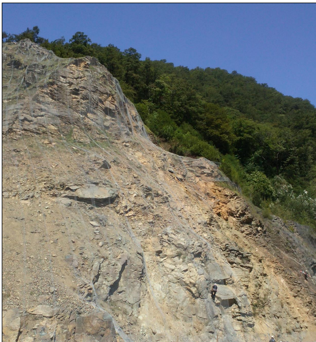
Рис. 4. Снимок поверхности склона в районе проектирования тоннельных переходов.
