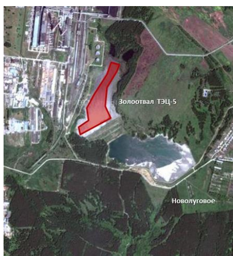
Рис. 1а. Золоотвал ТЭЦ-5 г. Новосибирска
