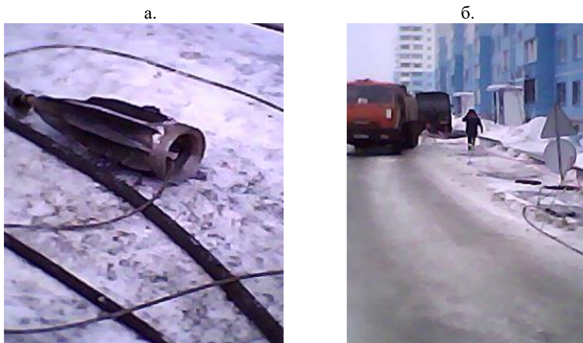
Рис. 3. Испытания г. Новосибирск:
