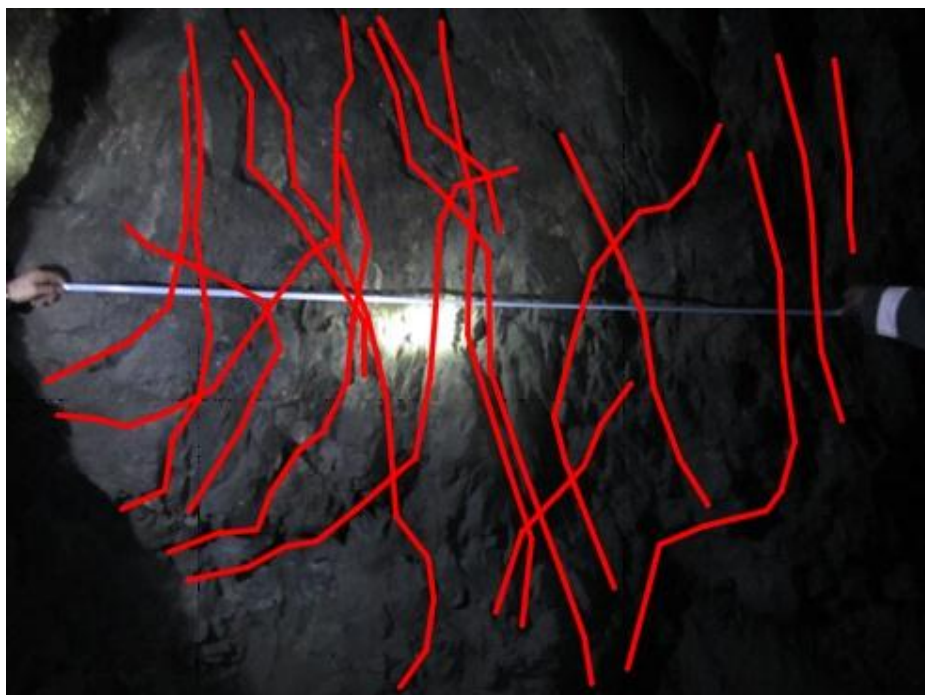
Рис. 3. Фотография с наложением трещин богатой руде на борту РШ л12 шахты «Скалистая» (пикет 374)
