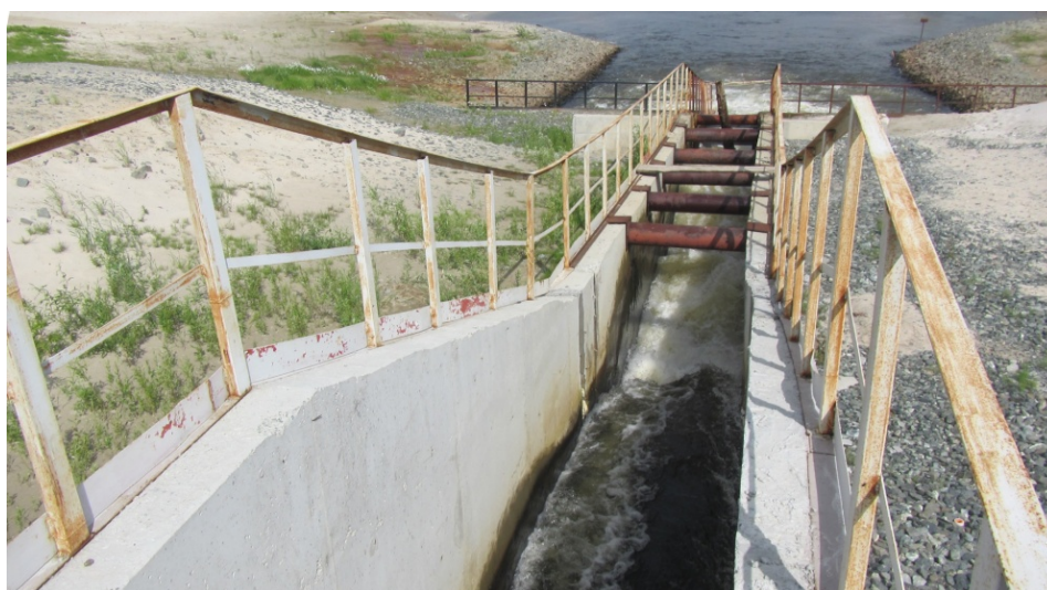
Рис. 2. Общий вид двухступенчатого перепада с установленными распорками
