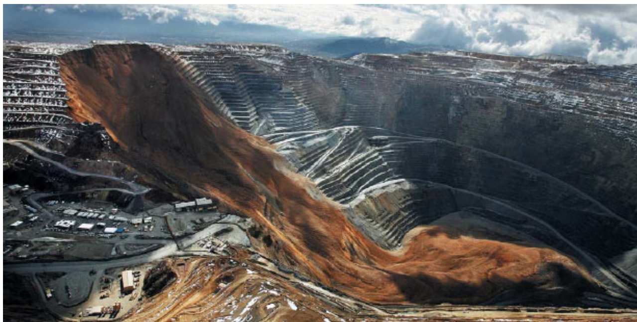
Рис.5. Сход горной массы на карьере Бингем-Каньон
