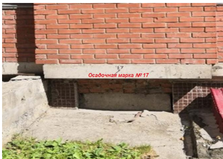
Рис. 1. Осадочная марка
