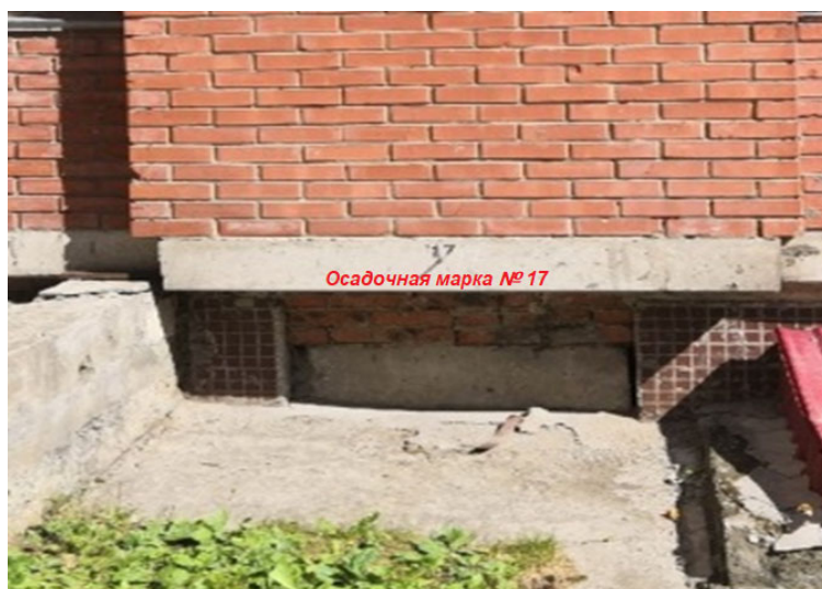
Рис. 1. Осадочная марка
