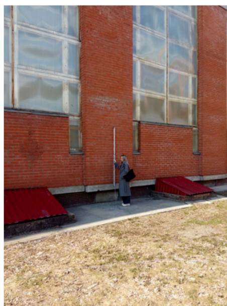
Рис. 2. Установка рейки на осадочную марку при наблюдении за осадками
