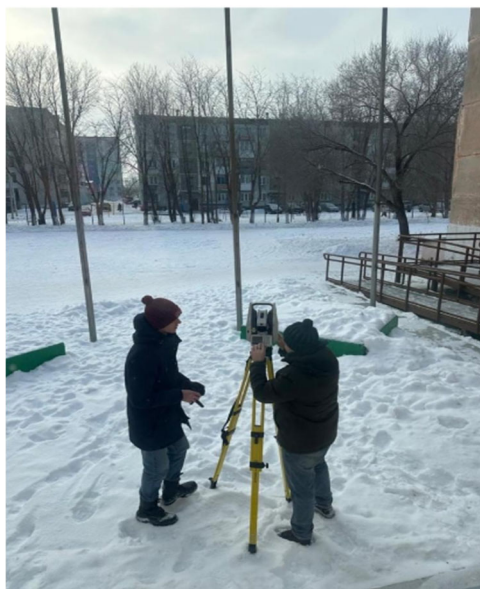
Рис. 2. Обмерные работы фасада здания
