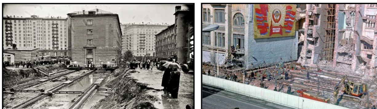
Рис. 1. Перемещение многоквартирных домов
