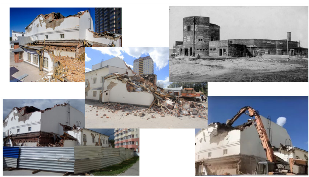
Рис. 4. Здание кинотеатра «Металлист» г. Новосибирск
