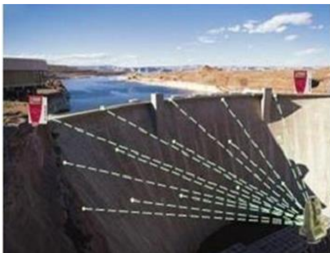
Рис. 1. Система мониторинга Leica GeoMoS
