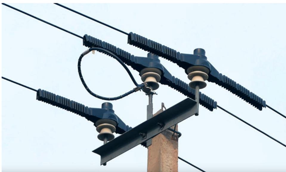
Рис. 2. Самонесущий изолированный провод для сетей 6-10 кВ
