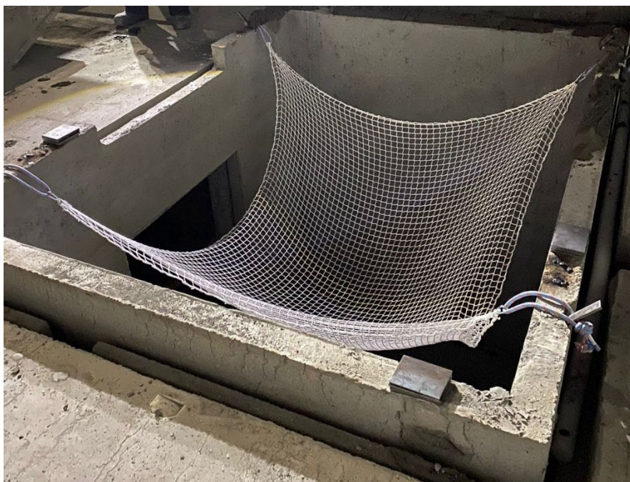
Рис. 1. Защитно-улавливающая система из полиамидной нити
