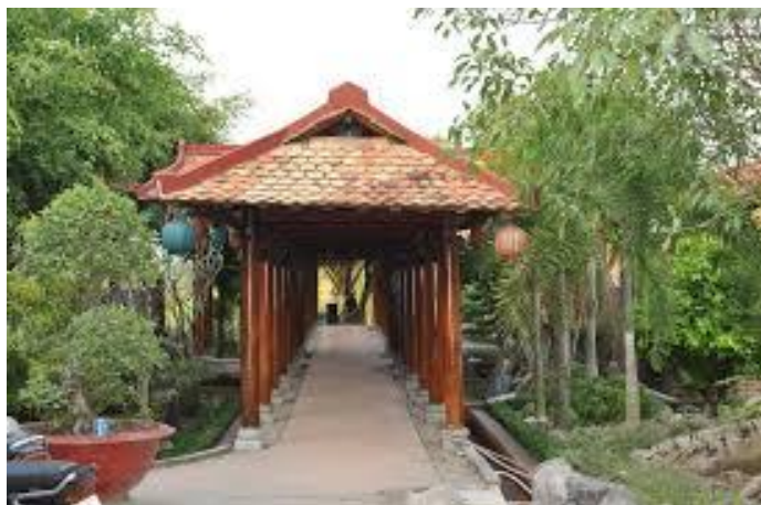
Рисунок 11 – Пешеходный переход с крышей – вид объекта «навес на столбах»
