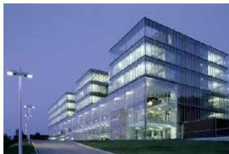
Рисунок 4 – Здание со стеклянной стеной и крышей
