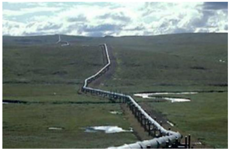
Рисунок 6 – Труба над земной поверхностью
