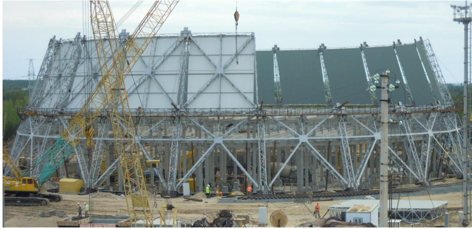
Рисунок 3.11 – Монтаж первого яруса башенной градирни НГРЭС
