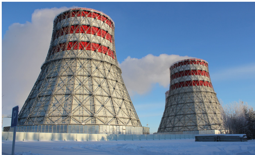
Рисунок 3.1 – Общий вид башенной градирни Няганской ГРЭС
