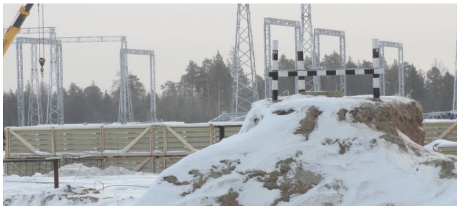
Рисунок 2.20 – ПСС перед котлованом ПГУ-1
