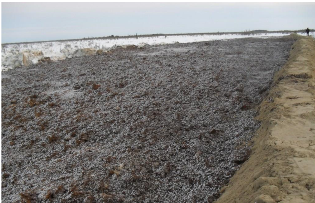
Рисунок 4 – Рекультивация накопителей отходов бурения
