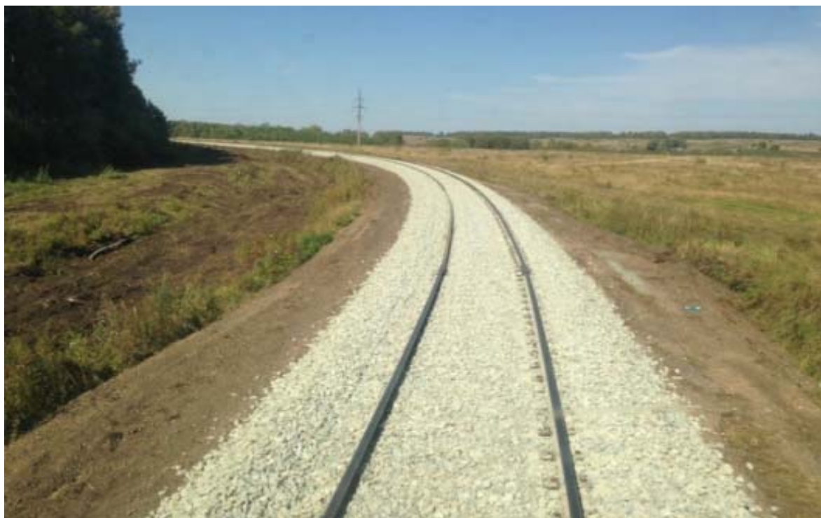
Рисунок 49 – Фрагмент пути после постановки в проектное положение САУ-3D ЭЛБ
