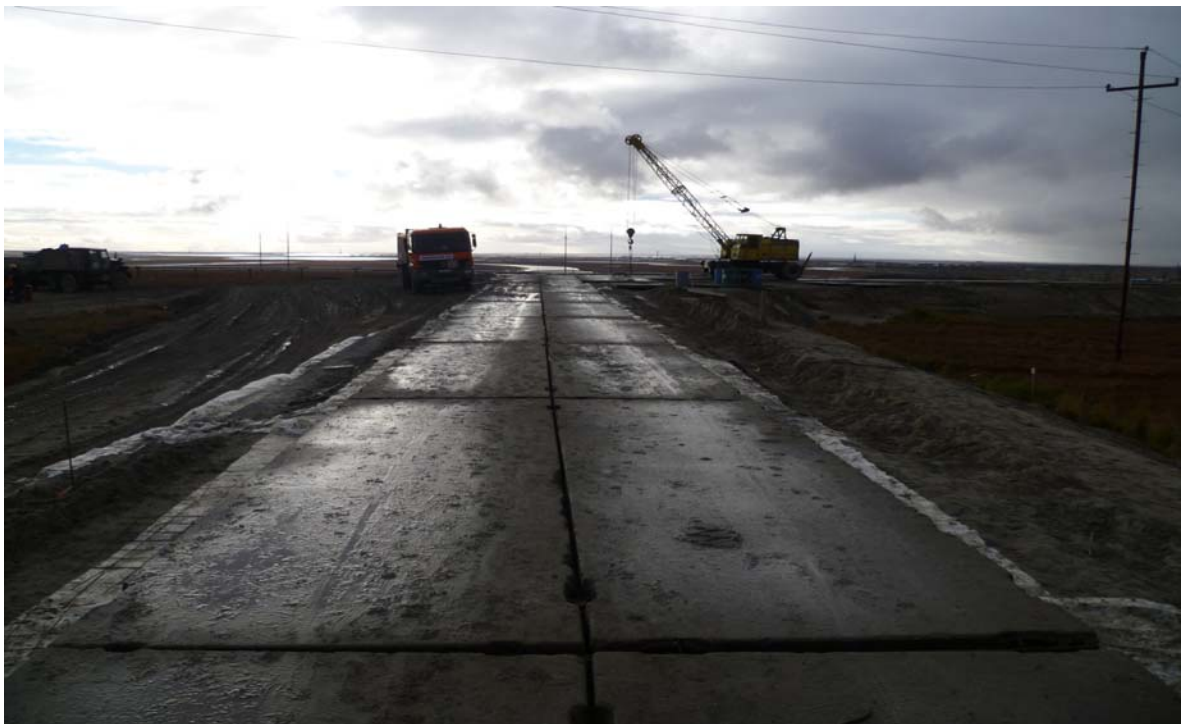
Рисунок 37 – Фрагмент подъездной дороги на Бованенковском месторождении
