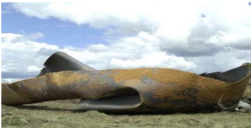
Рисунок 4 – Результат взрыва магистрального газопровода
