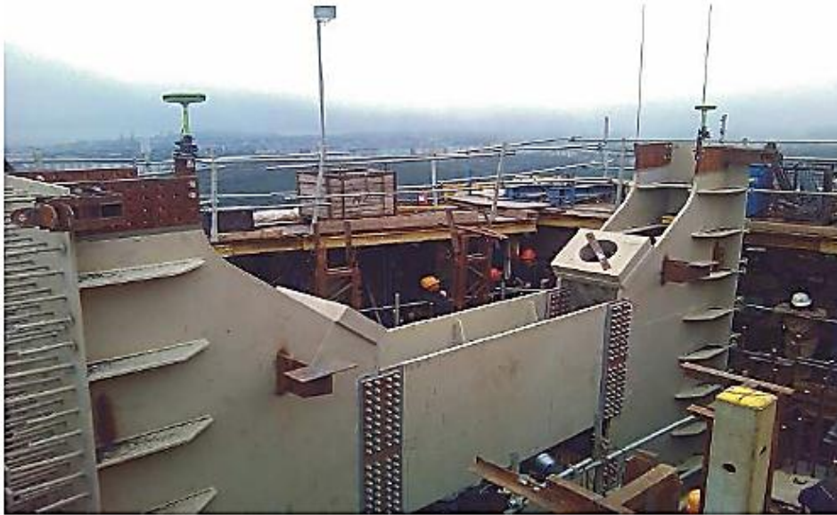
Рисунок 4.7 – Геодезический контроль опор мостов с применением приёмников ГНСС
