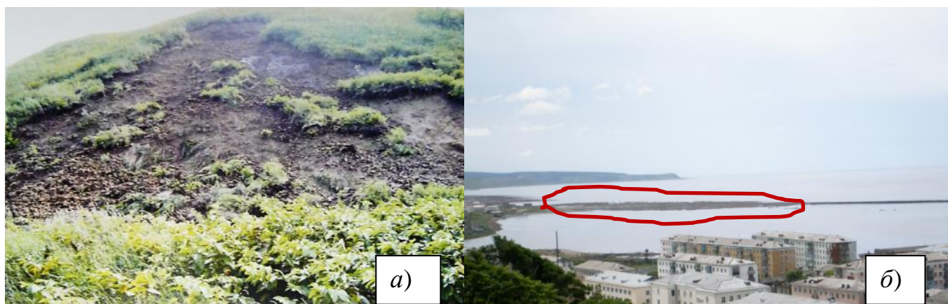
Рисунок 2.7 – Последствия тектонических подвижек:
