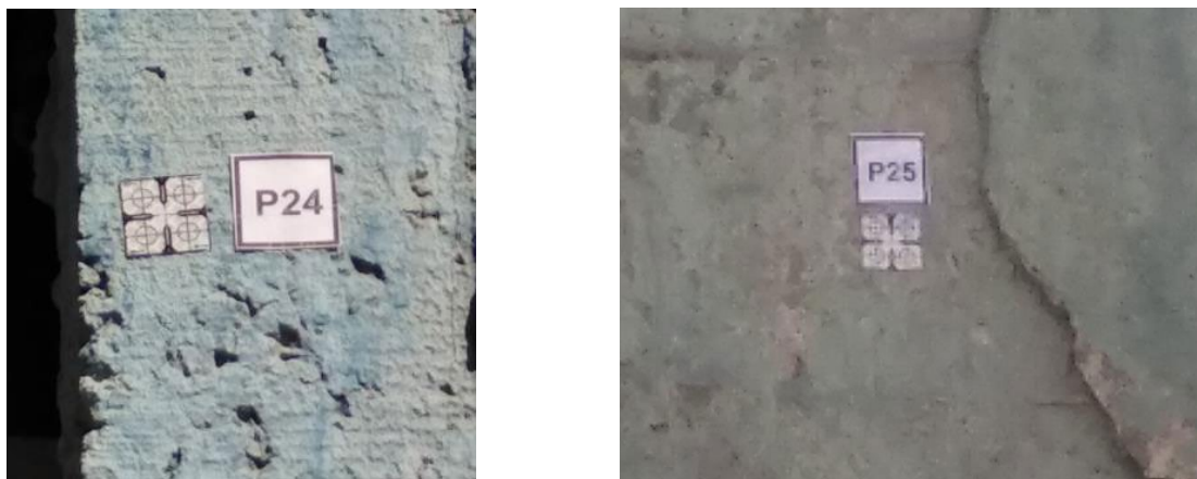
Рисунок 2.1 – Способы закрепления опорной геодезической сети
