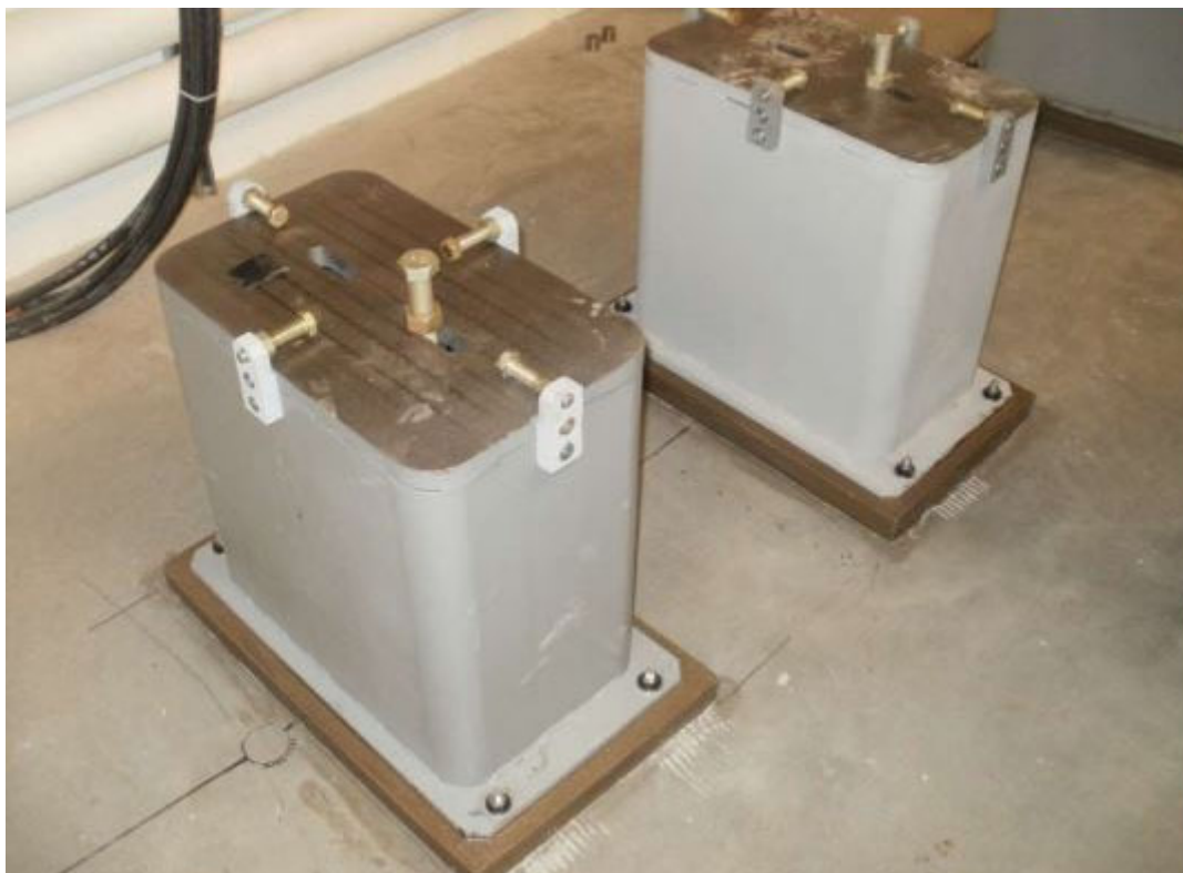
Рисунок 1.23 – Установленные опорные конструкции гирдера относительно вынесенной линии оси
