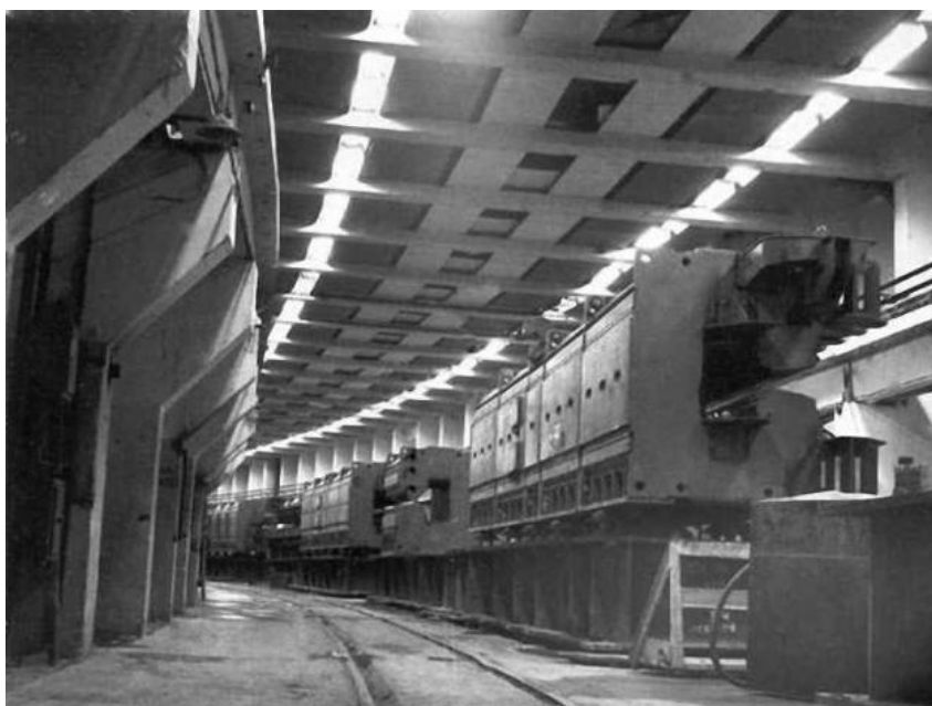
Рисунок 1.8 – Монтаж электромагнитов в тоннеле ускорителя У-70
