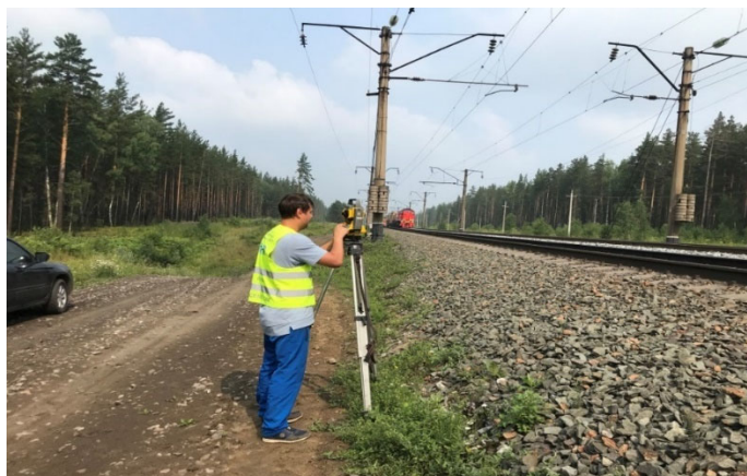
Рисунок 3.15 – Контроль уплотнения балласта инструментальными геодезическими методами
