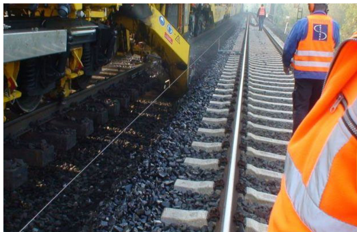
Рисунок 1.6 – Методы постановки пути в проектное положение с использованием копировальной струны
