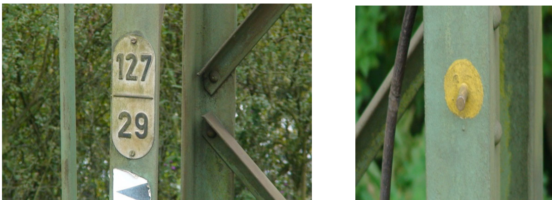
Рисунок 1.7 – Реперы на опорах контактной сети германских железных дорог для выноса в натуру высотных отметок и плановых координат
