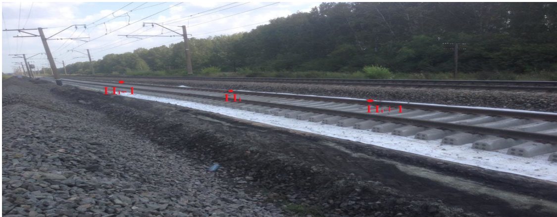
Рисунок 3.7 – Основная площадка после вырезки балласта
