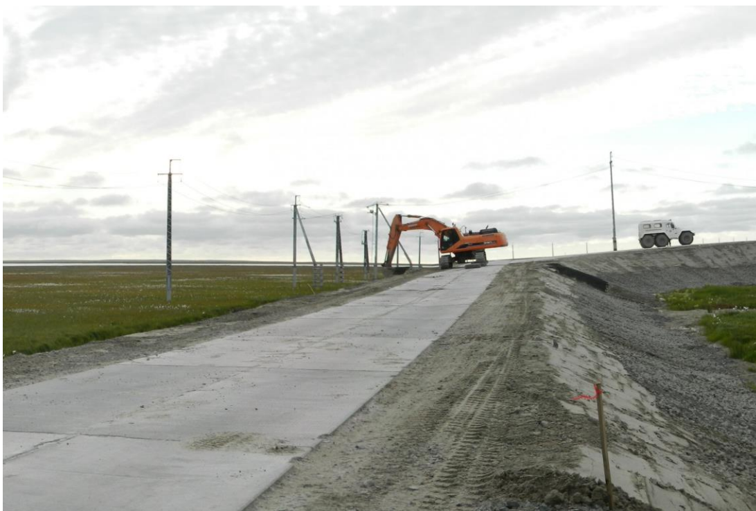
Рисунок 17 – Фрагмент подъездной дороги на Бованенковском месторождении
