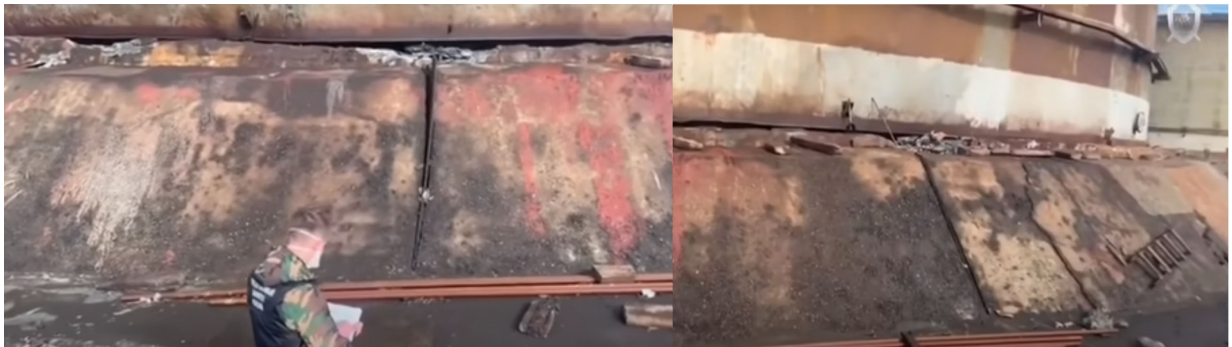
Рисунок 2.3 – Резервуары Норильской ТЭЦ: a) общий вид резервуарного парка; б) деформированное днище резервуара
