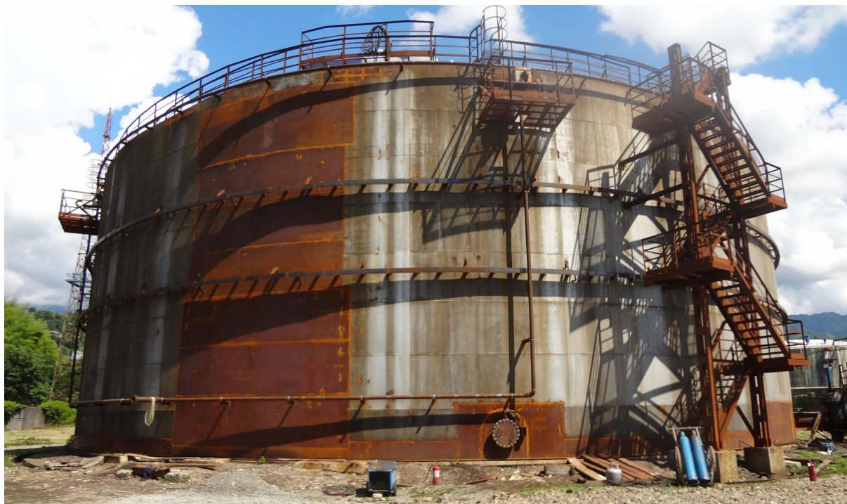
Рисунок 2.4 – Усиление резервуара в процессе ремонта
