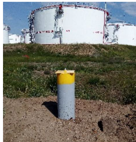
Рисунок 2.5 – Закрепление пунктов на местности
