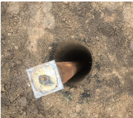
Рисунок 2.5 – Закрепление пунктов на местности
