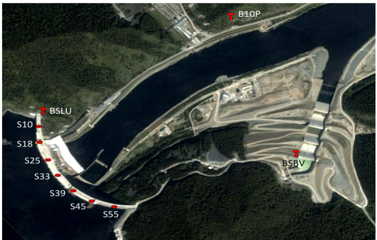
Рисунок 1.26 – Система мониторинга плотины Саяно-Шушенской ГЭС [3]
