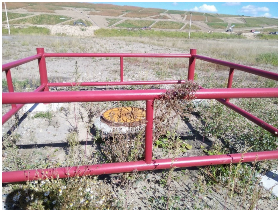
Рисунок 2.7 – Общий вид фундаментального репера высотной опорной сети Загорской ГАЭС-2
