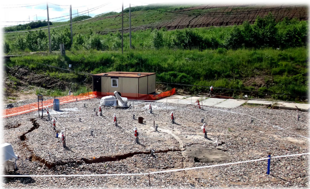
Рисунок. 2.26 – Общий вид ОУ № 3 после выполнения работ по подъему
