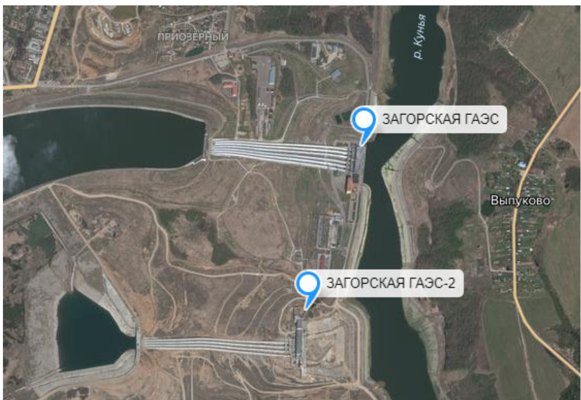
Рисунок 2.1 – Действующая Загорская ГАЭС и строящаяся Загорская ГАЭС-2
