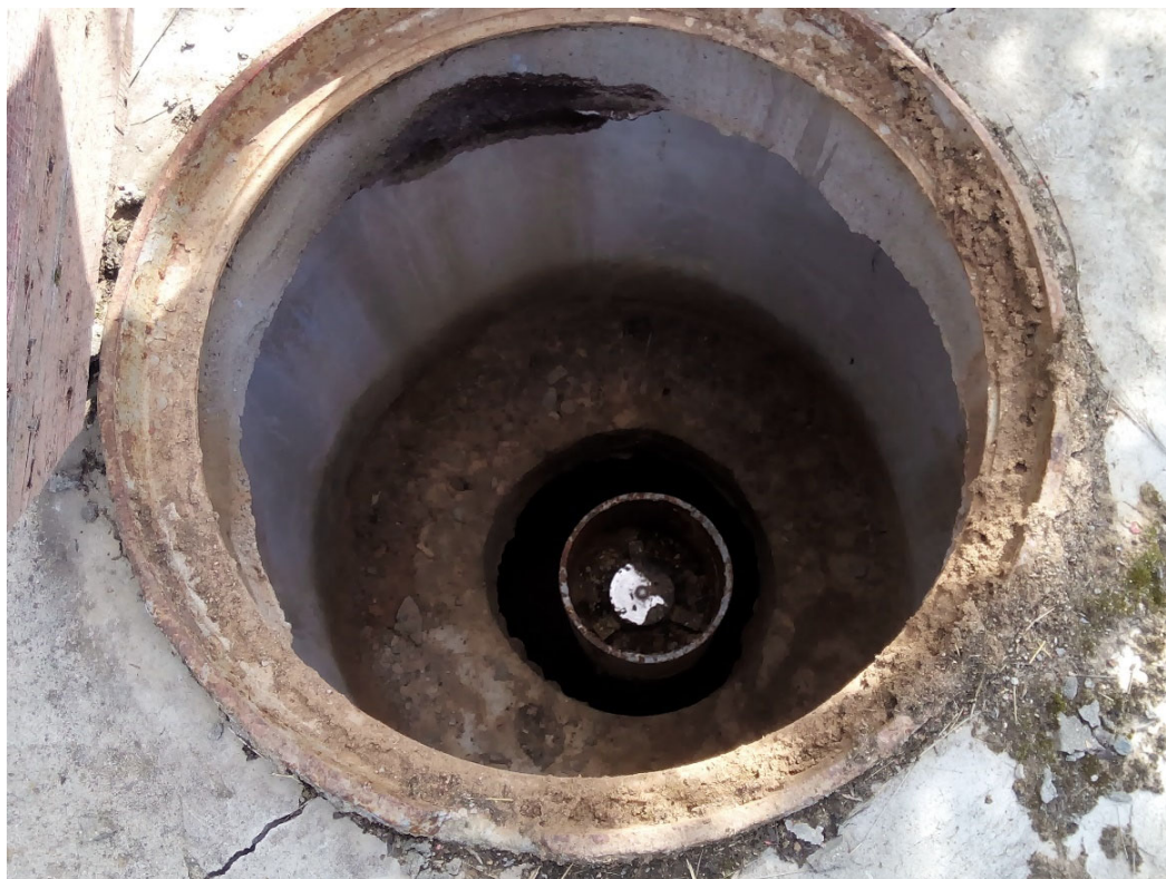
Рисунок 2.8 – Центр фундаментального репера высотной опорной сети Загорской ГАЭС-2
