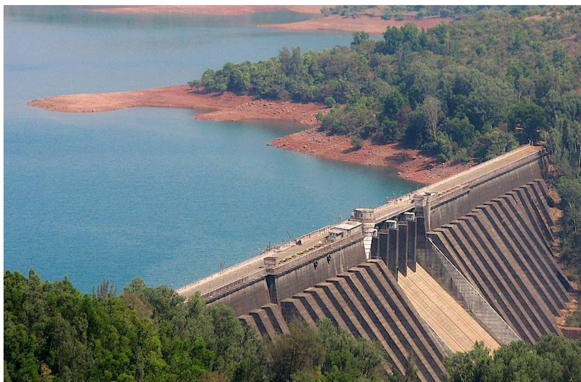
Рисунок 1.22 – Общий вид плотины Койна
