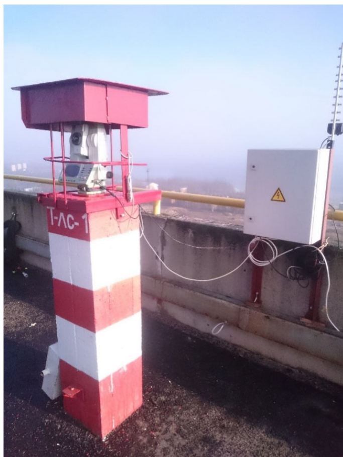
Рисунок 1.7 – Электронный тахеометр Leica TM30, установленный на ГТС
