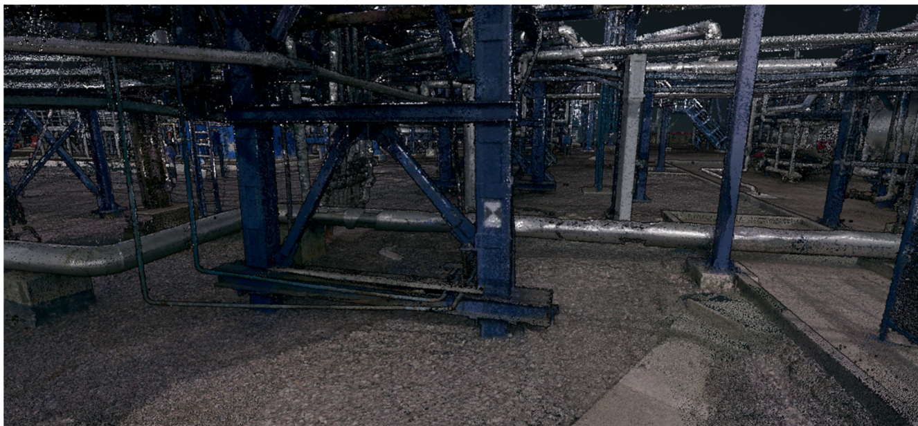
Рисунок 4.19 – Опорная точка (марка) наземного лазерного сканирования в облаке точек
