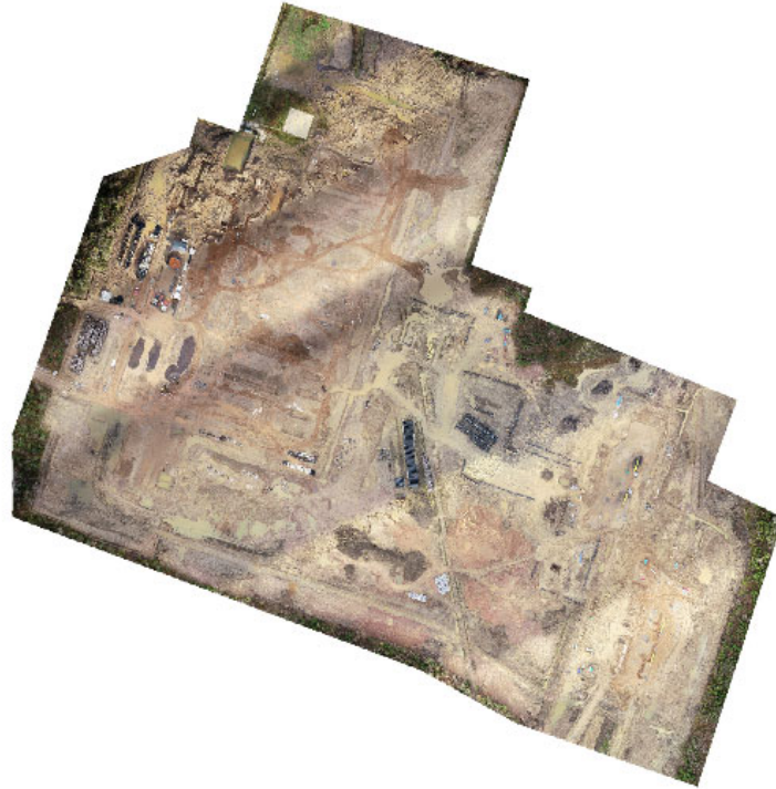
Рисунок 4.13 – Ортофотоплан площадки строительства площадочного объекта трубопроводного транспорта
