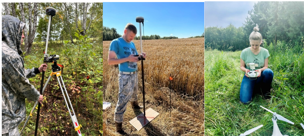
Рисунок 18 – Проведение планово-высотного обоснования и аэрофотосъемки (фотографии размещены с согласия привлеченного к исследованию геодезиста А. О. Ливадного)
