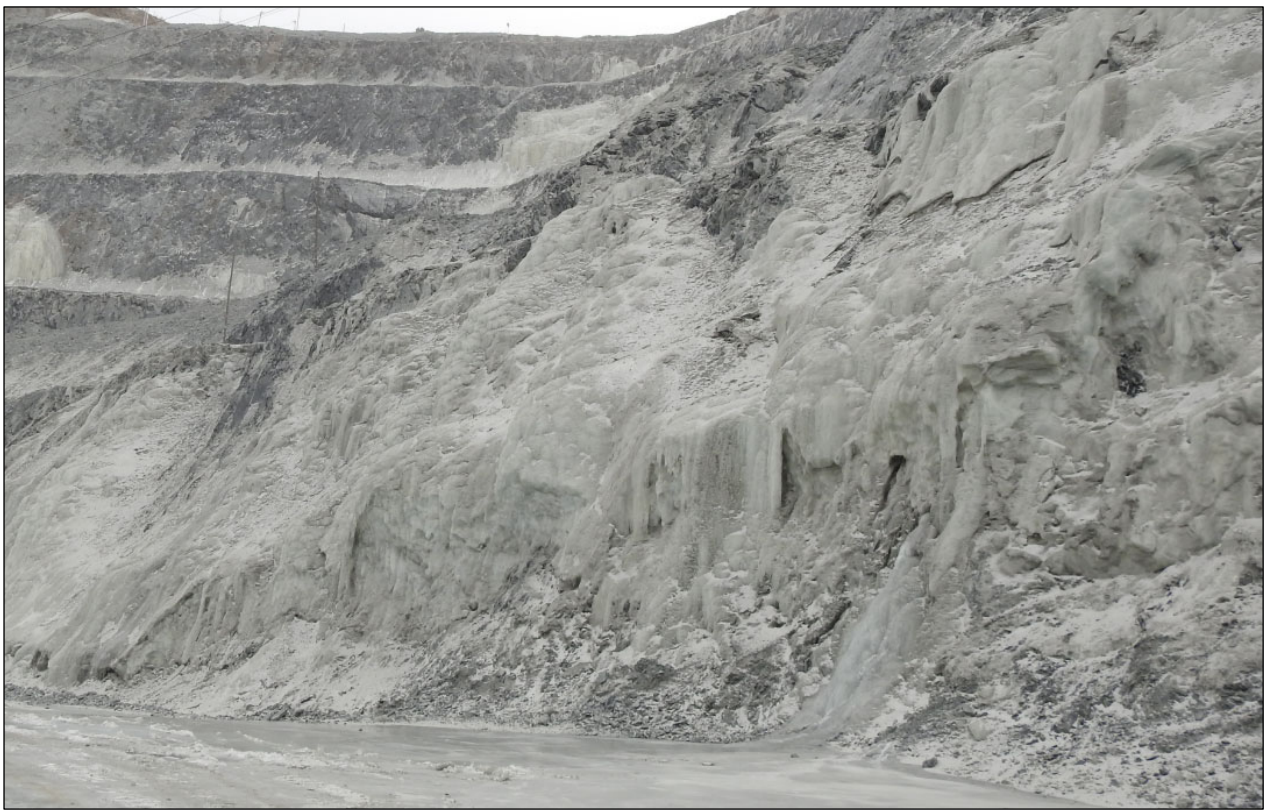
Рисунок 38 – Пример сильнообводненного участка борта в весеннее время
