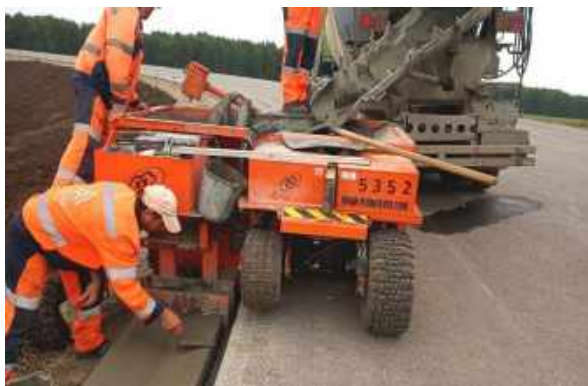
Рисунок 7 - Кладка монолитных бетонных лотков на развязке трассы Р 254
