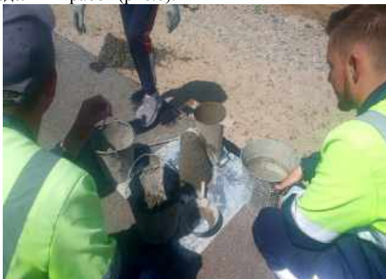
Рисунок 6 - Проверка подвижности бетонной смеси водоотводных лотков
