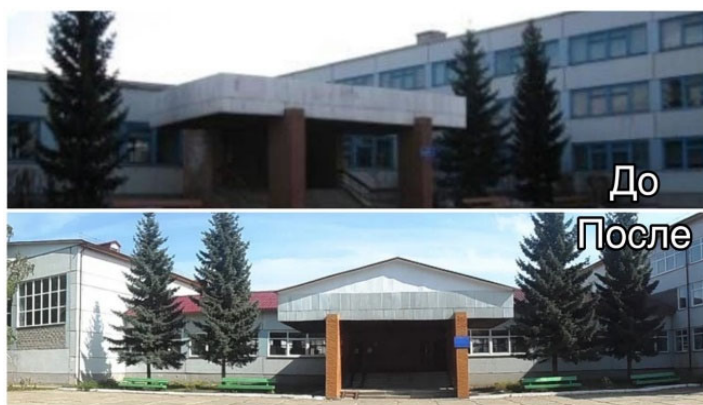
Крыша школы до и после ремонта
